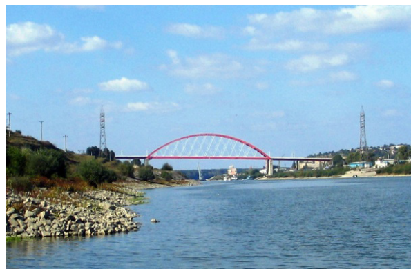
Fig. 8 Podul rutier cu structură Nielsen peste canalul Dunăre-Marea Neagră la Cernavodă Gară.
