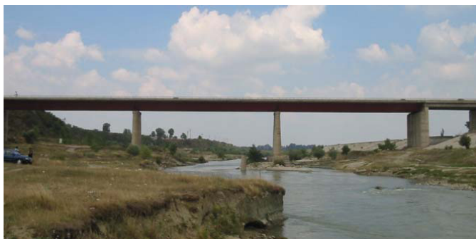
Fig. 7 Podul peste canalul București-Dunăre la Adunații Copăcenii. Vedere generală
