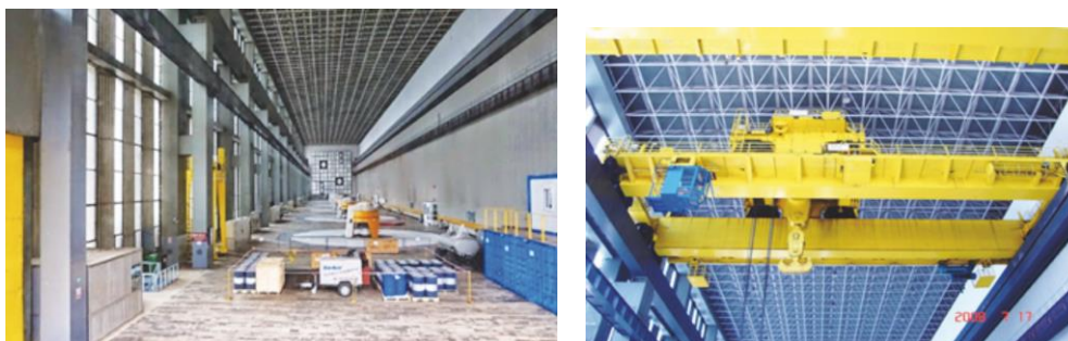
Sala mașinilor de la CHE PF I, cu structura reticulată a acoperișului, sistem care se aplica în premieră în România și podul rulant de 400 t, cel mai mare din țară.
