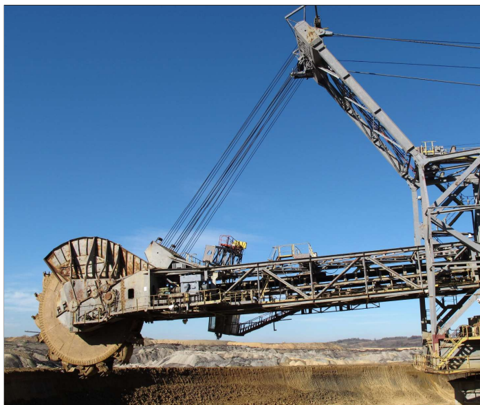
Instalație performantă de exploatare a lignitului (Cariera de la Rovinari)
