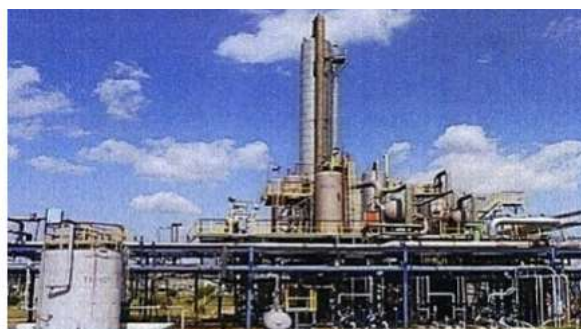
Instalația de polietilenă de mare densitate DPB Pitești
