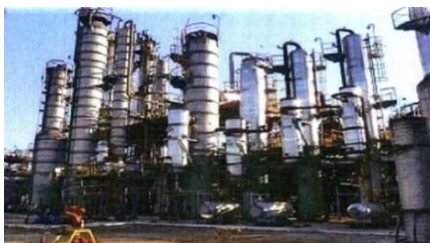
Instalația de oxid de etilenă și glicoli DPB Pitești
