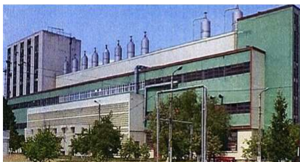
Instalația de polietilenă de mică densitate DPB Pitești
