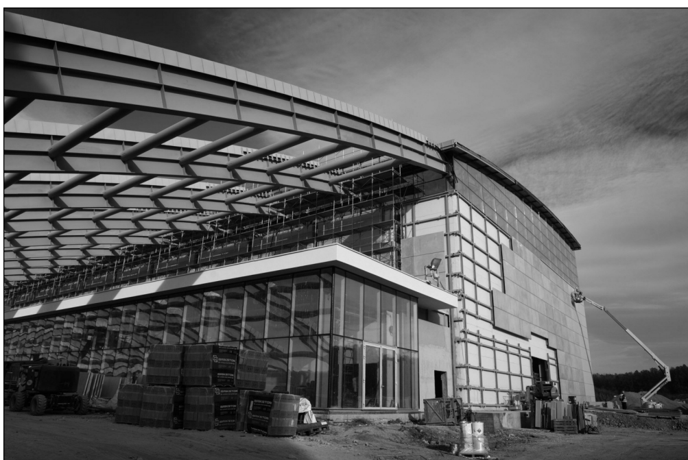
Clădirea de la Măgurele care va găzdui cel mai mare laser
